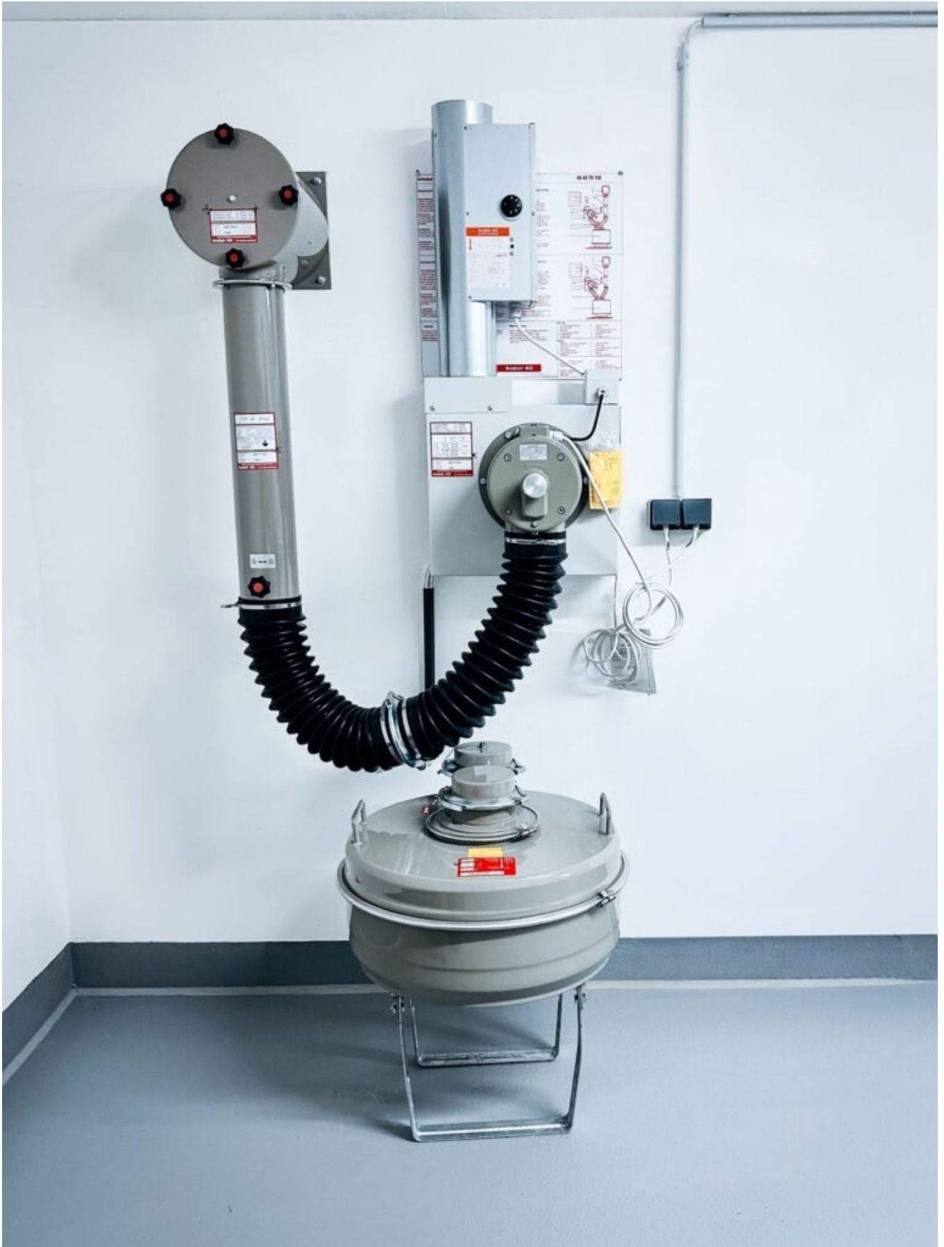
Gasfilteranlage
