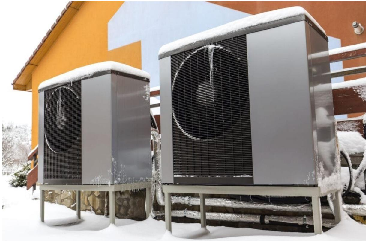
Bei höherem Heizwärmebedarf kann die Wärmeleistung auf zwei Luft-Wasser-Wärmepumpen verteilt werden – Fachleute sprechen dann von einer Kaskade. Die beiden Geräte hier sind erhöht aufgestellt, um auch bei größeren Schneemengen zuverlässig arbeiten zu können.
