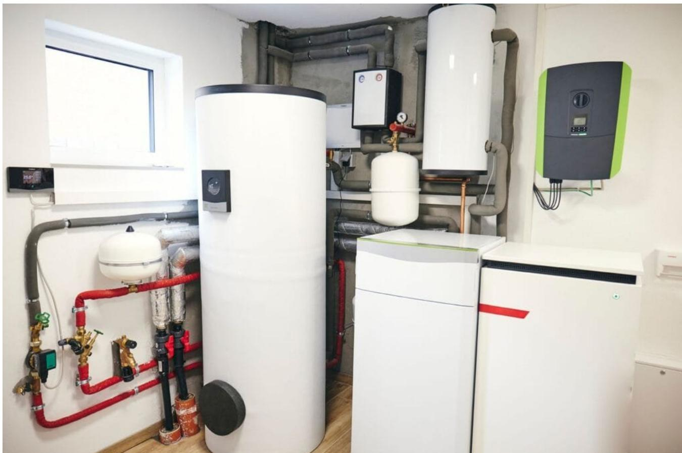
Die kompakten Erdwärmepumpen (Bildmitte) werden im Eigenheimbereich üblicherweise im Gebäudeinneren aufgestellt. Die aktuellen Gerätegenerationen nutzen dabei das natürliche Kältemittel Propan (R290). Foto: Thilo Ross/Intelligent heizen
