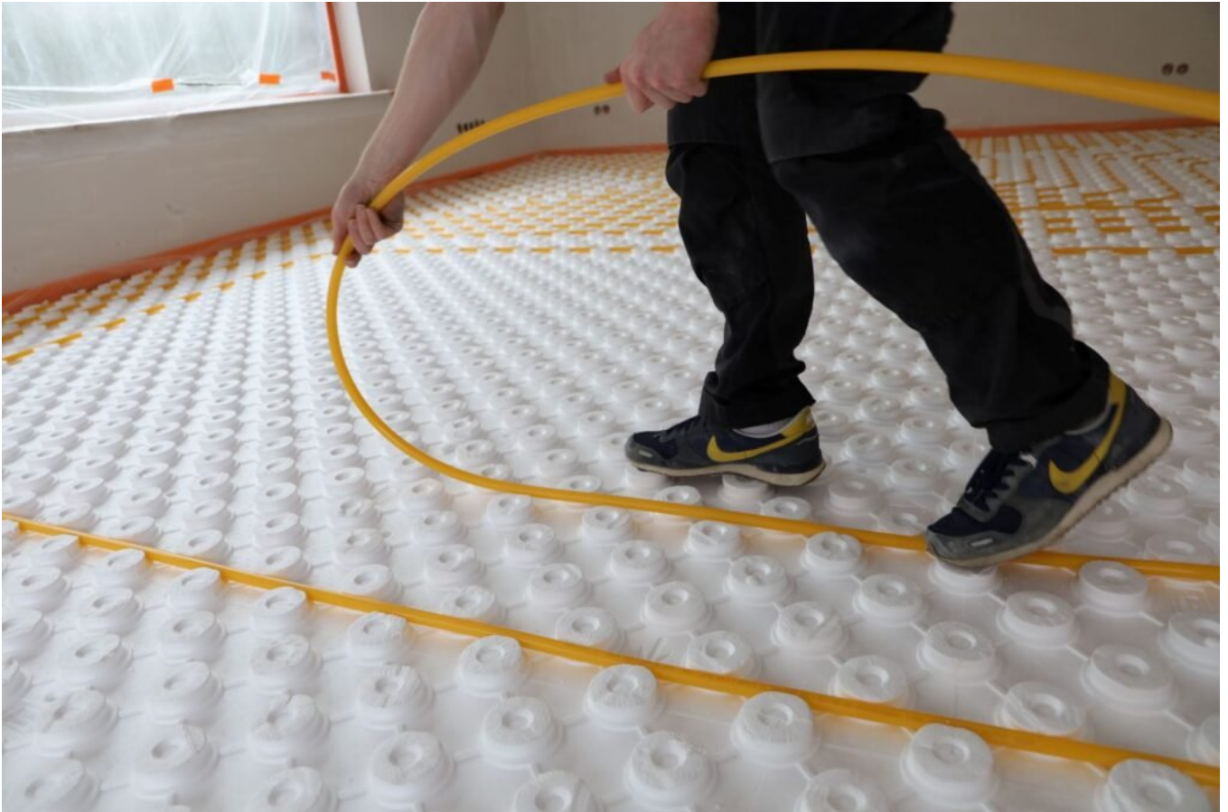
3. Die Verlegung der neuen Heizrohre: Eine dünn-schichtige und energieeffiziente Fußbodenheizung in Kombination mit keramischen Fliesen war für das Erdgeschoss von Anfang an vorgesehen.
