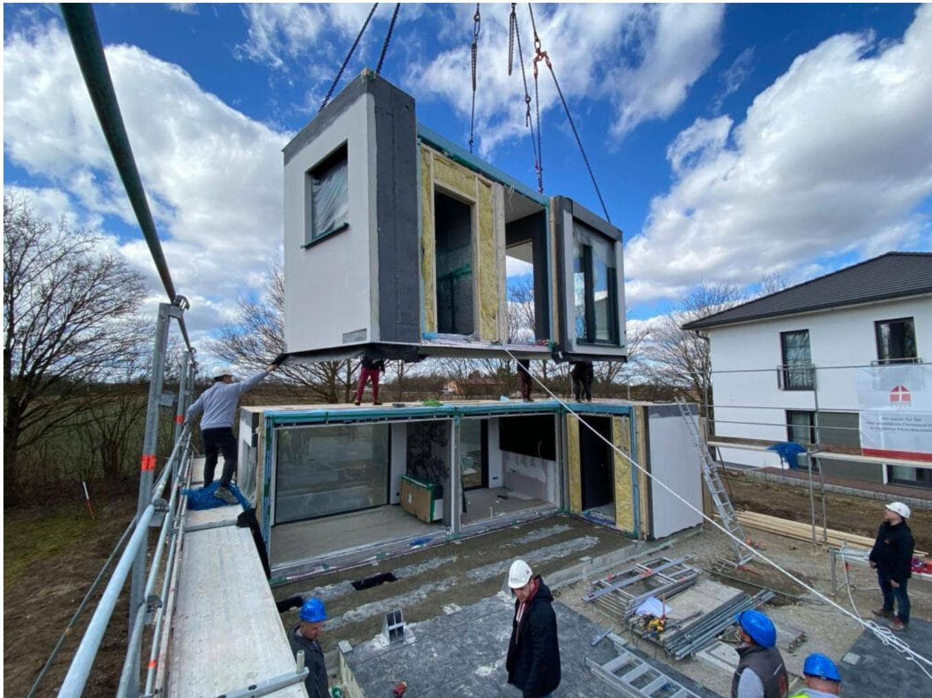
Die fertig ausgebauten Module werden per LKW auf die Baustelle gebracht. Mithilfe eines Autokrans werden sie angehoben und an ihren Bestimmungsort gesetzt. Zum Schluss werden die Module dicht und stabil miteinander verschraubt.
