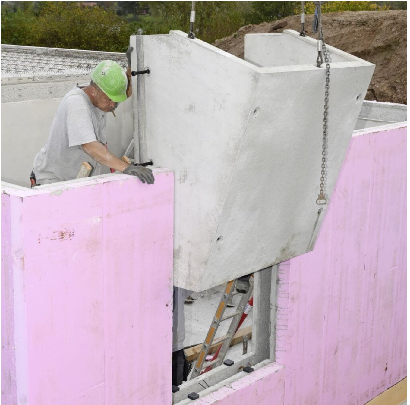
Auf der Baustelle wird der Lichtfluter exakt eingesetzt.
