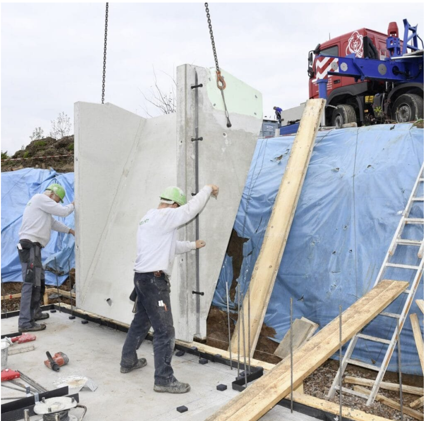
Präzisionsarbeit: Der original Lichtfluter wird von KNECHT Kellerbau im Werk vorgefertigt.
