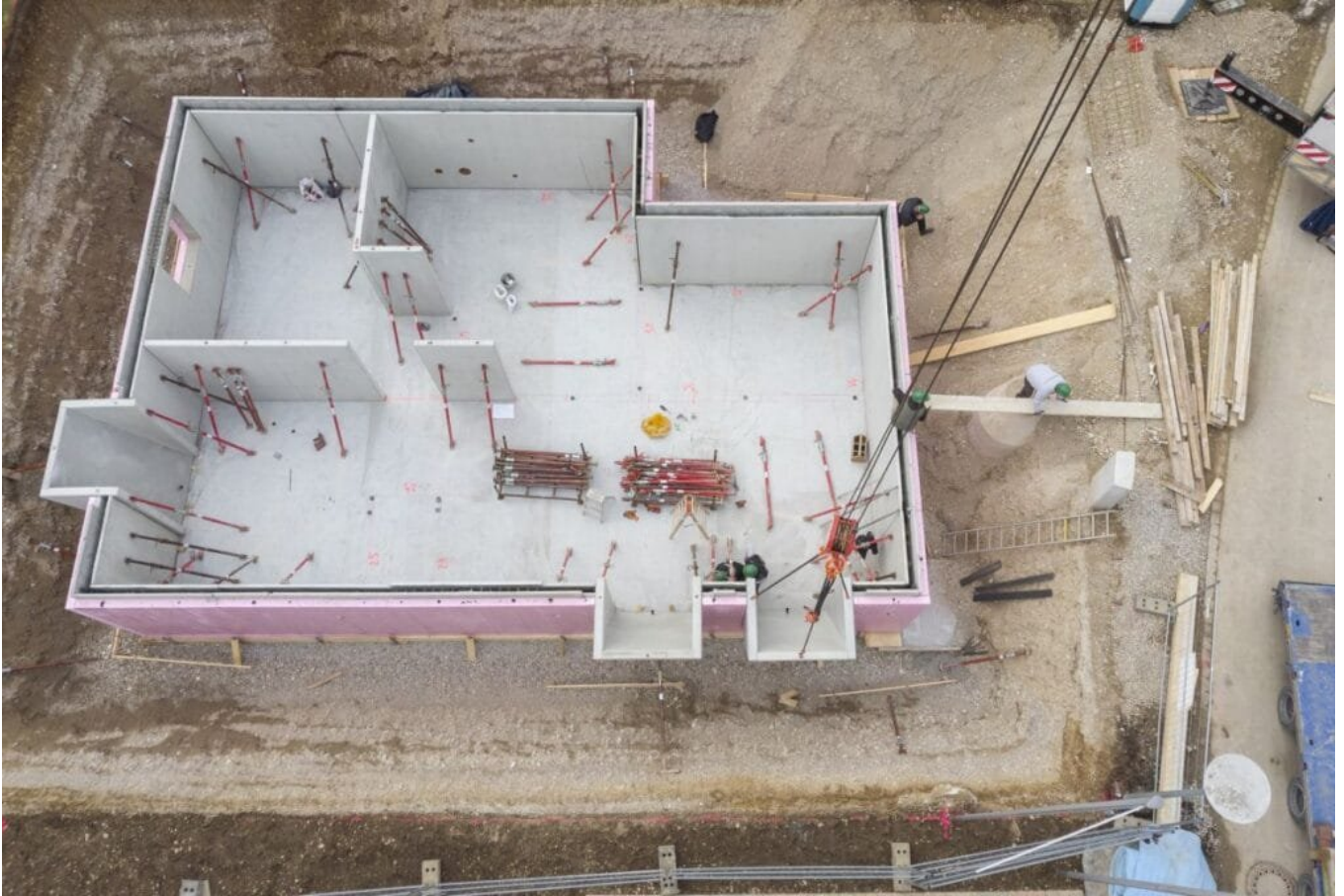
Maßarbeit auf der Baustelle von KNECHT Kellerbau: Gut zu sehen, die drei Lichtfluter.
