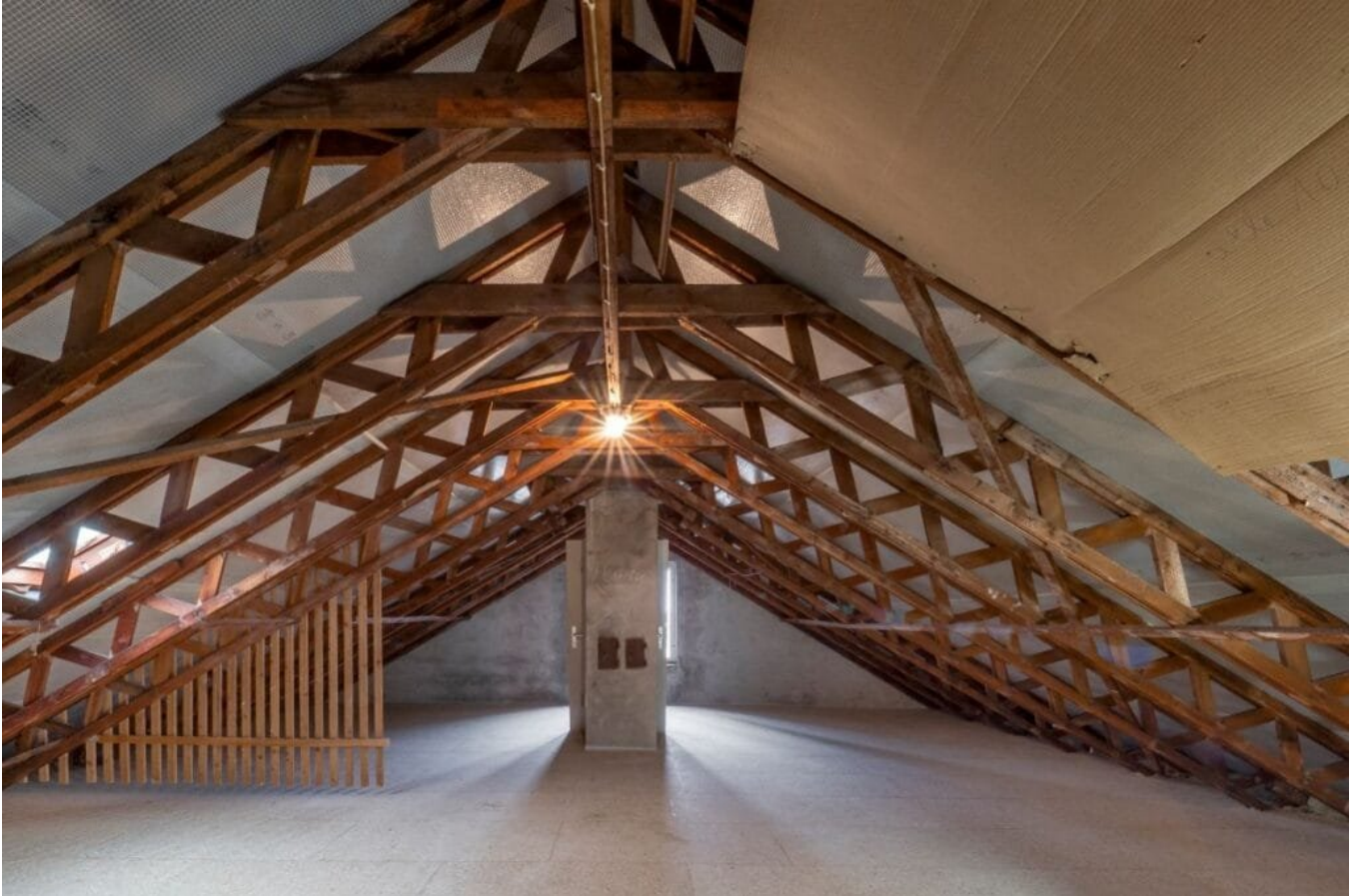
Der begehbare, belastbare und gut gedämmte Dachboden nach der Verlegung. Fotos Linzmeier / Oliver Heini
