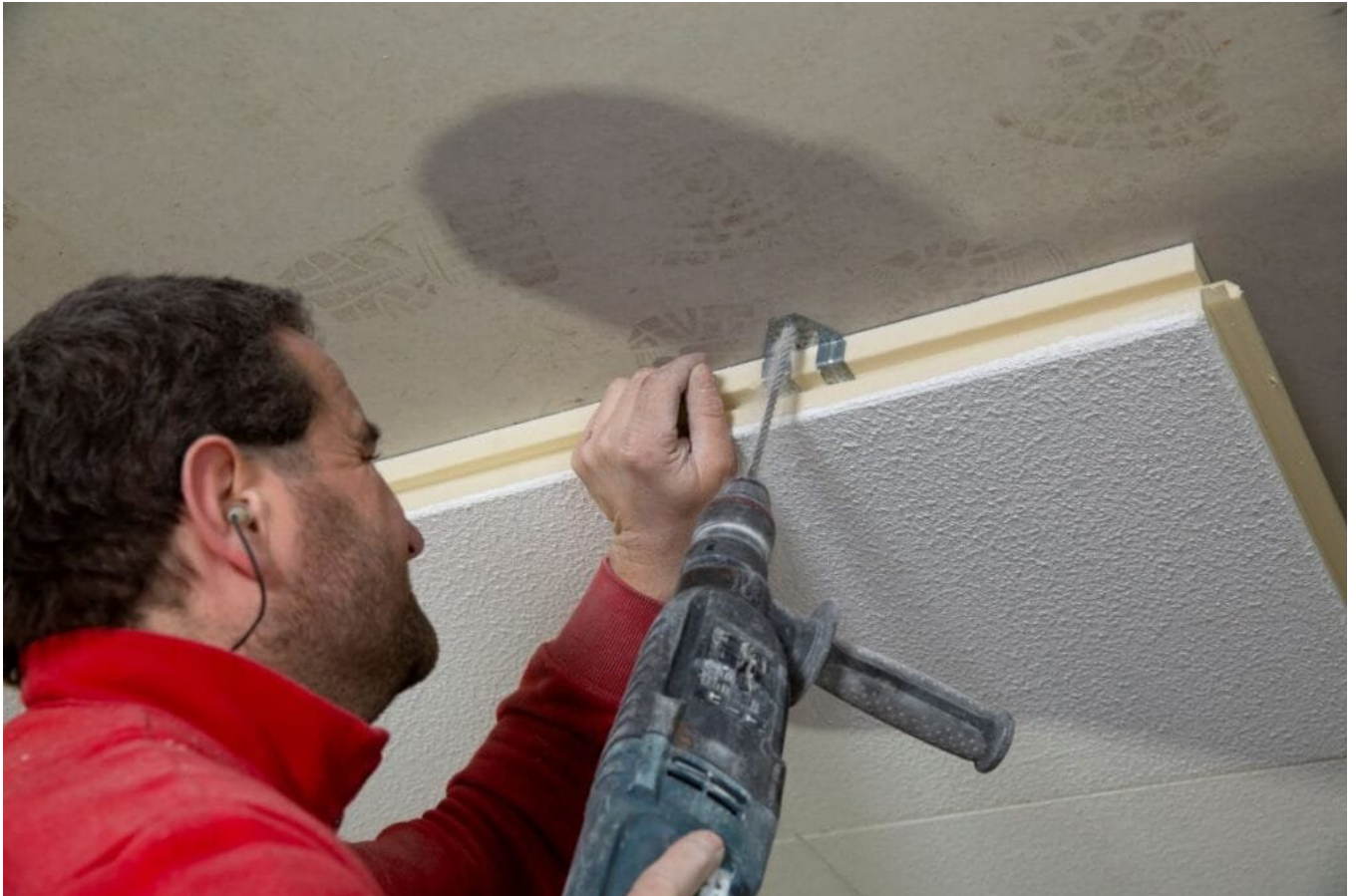
LINITHERM PAL KD BioZell und KD N+F – mechanische Befestigung mit Befestigungsklammern. Foto Linzmeier
