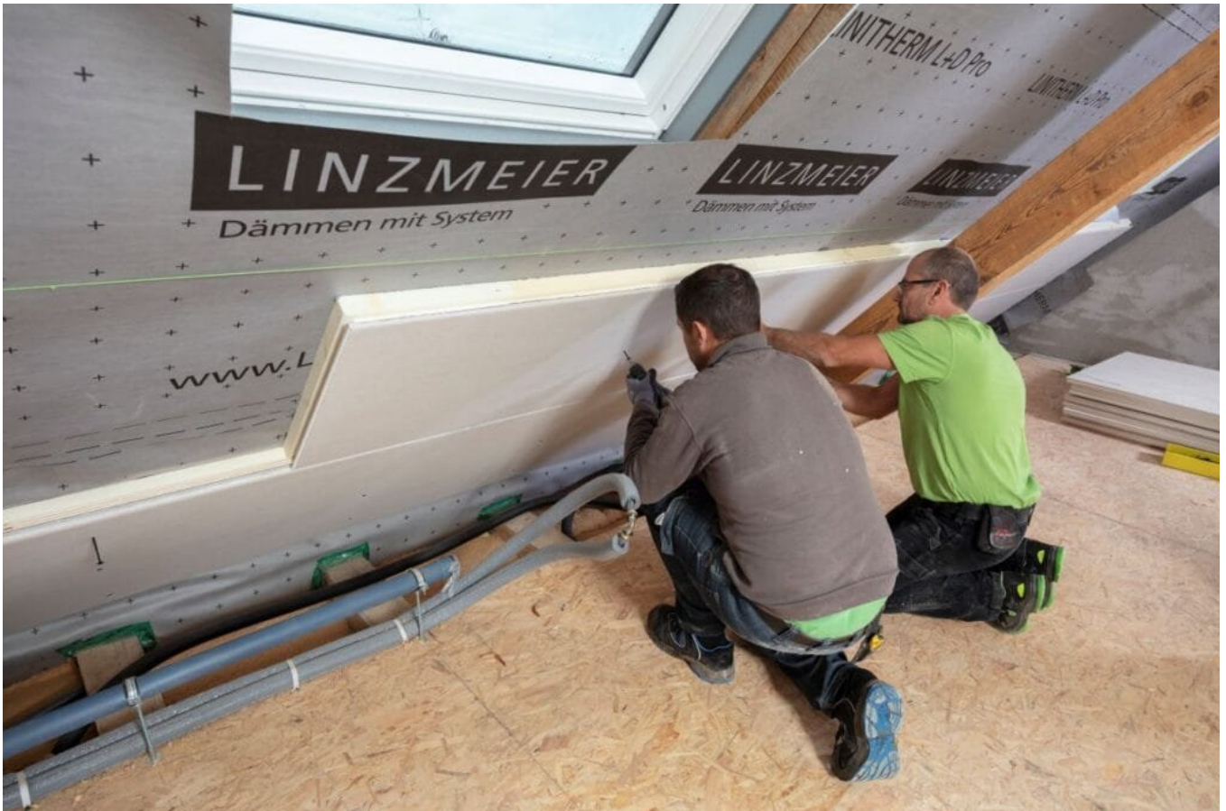
LINITHERM PAL GK - Anbringung der Dämmplatten mit aufkaschierter Gipskartonplatte. Fotos Linzmeier
