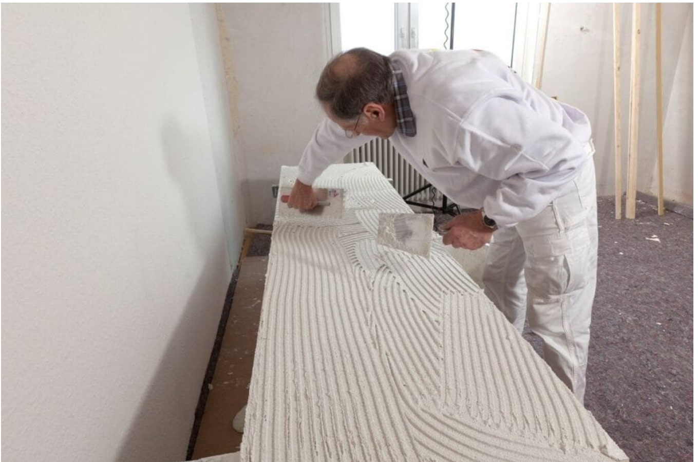
LINITHERM PAL SIL - Auftragen des Klebers. Fotos Linzmeier
