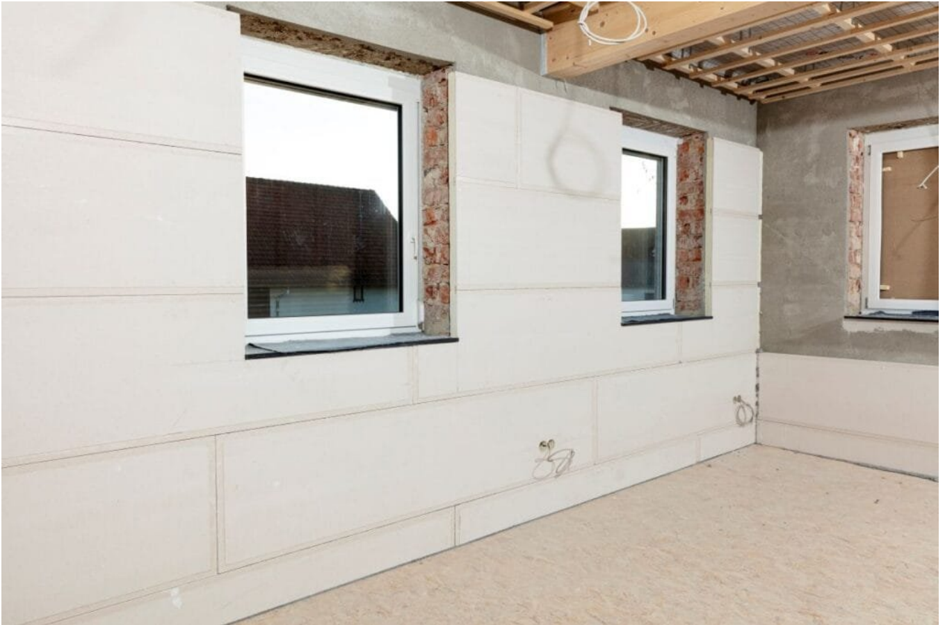
LINITHERM PAL SIL – nach dem Spachteln ist die Wand tapezier-, streich- & verputzfähig.
