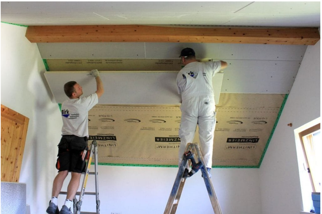
LINITHERM PAL GK -Dämmelement mit aufkaschierter Gipskartonplatte.
