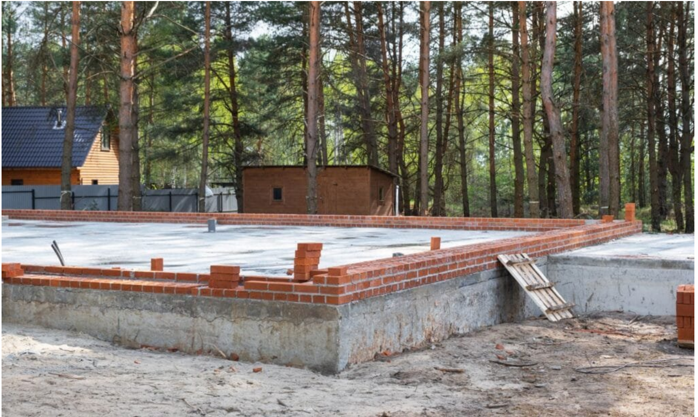
Das Fundament in Form einer Bodenplatte ist gesetzt, nun kann der Hausbau beginnen. Foto: www.elements.envato.com
