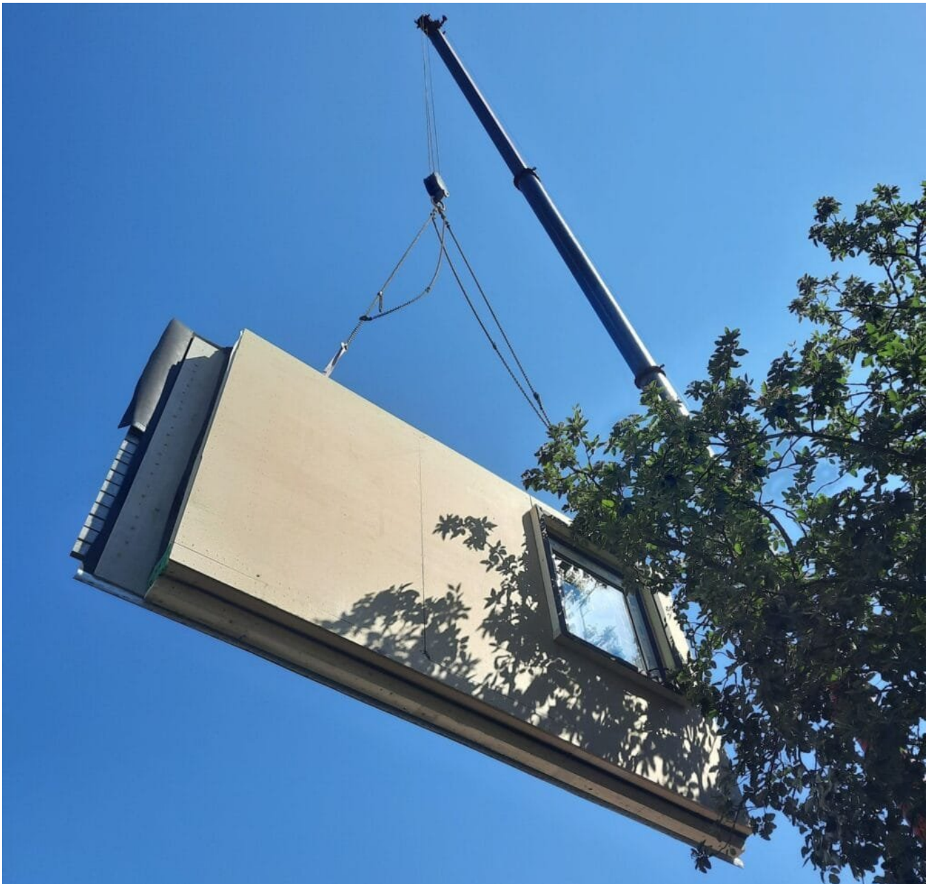
Diese gut gedämmte Außenwand hängt im Zuge einer seriellen Sanierung am Kran und wird in Kürze als neue Außenhülle um einen Altbau montiert. Foto: Sylvia Gatzka
