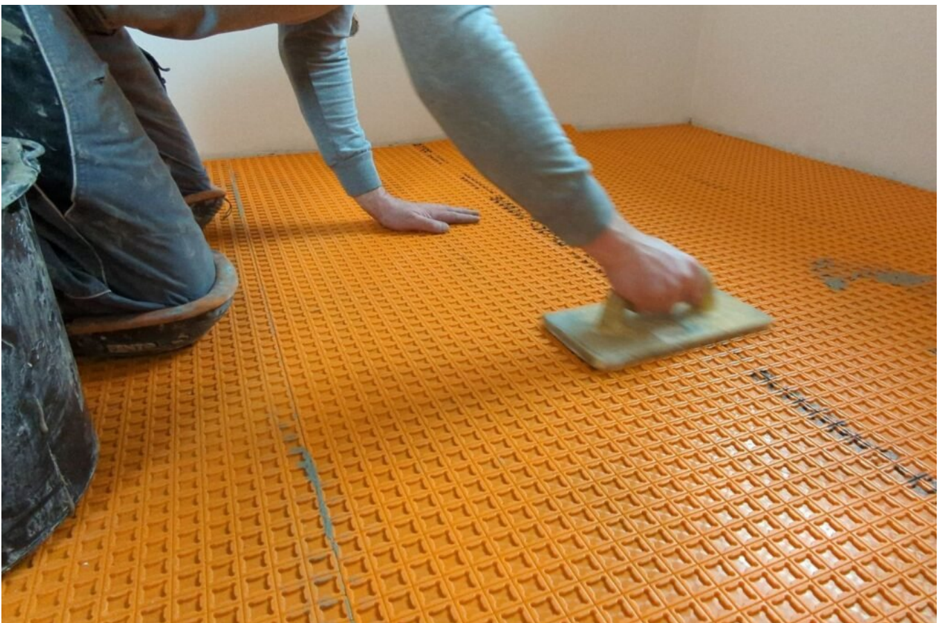
4. Die zum System gehörende Verbundentkopplungsmatte wird direkt nach der Begehrbarkeit des
