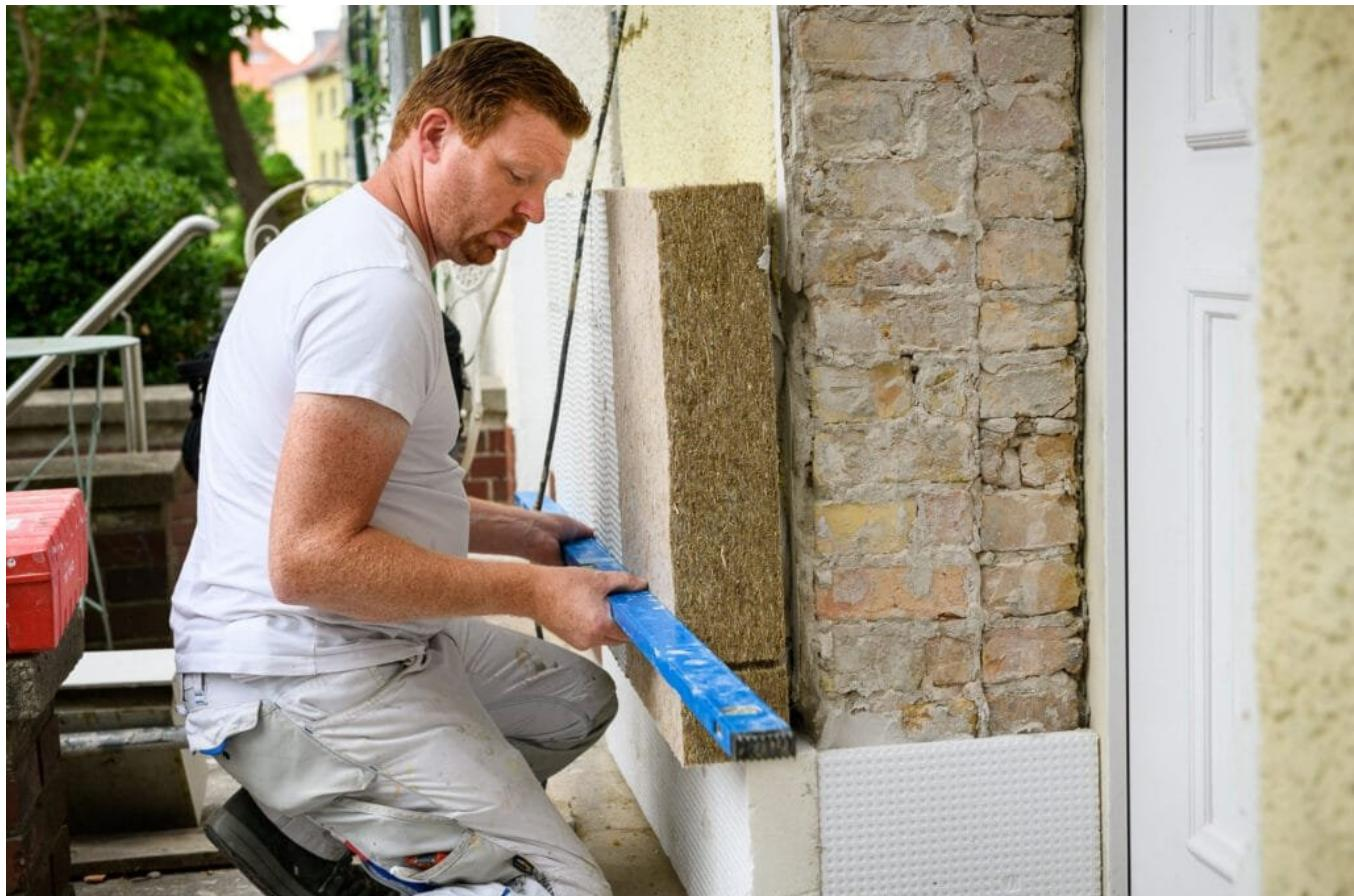
Mineralische Dämmstoffe, wie zum Beispiel Steinwolle für die Fassaden-Dämmung, sind nicht brennbar. Foto: [www.co2online.de](http://www.co2online.de)
