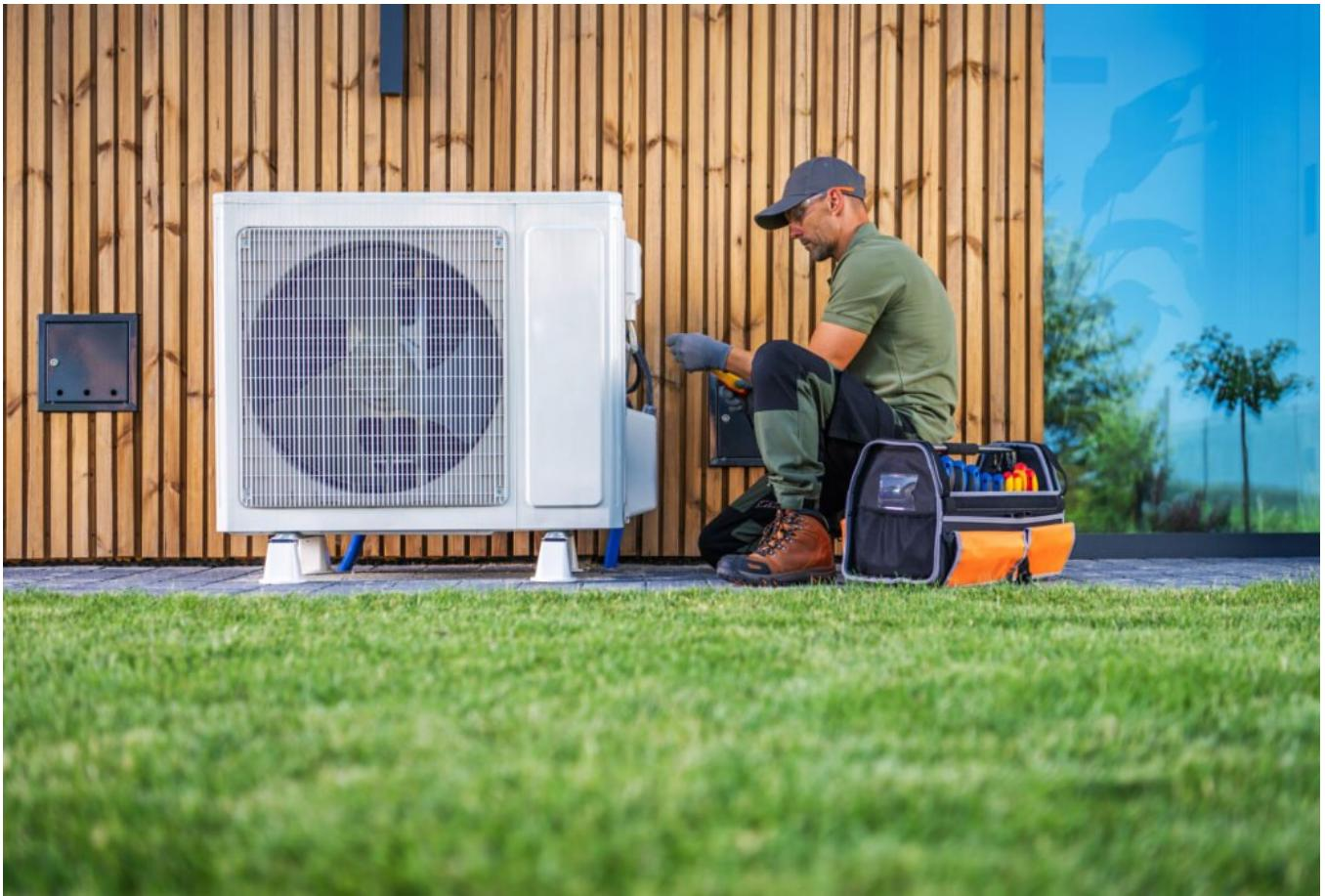
Der Clou beim Heizen mit der Wärmepumpe ist, dass sie – je nach verwendeter Wärmequelle – aus einer Kilowattstunde elektrischer Energie bis zu über vier Kilowattstunden Heizenergie erzeugen kann. Am beliebtesten bei deutschen Bauherren ist die Luft-Wasser-Wärmepumpe. Sie erreicht zwar nicht die maximale Effizienz – die Einbaukosten sind aber günstiger als bei erdgekoppelten Wärmepumpen. Einen ausführlichen Ratgeber zum Thema Wärmepumpen findest du [hier](#). Foto: elements.envato.com / duallogic
