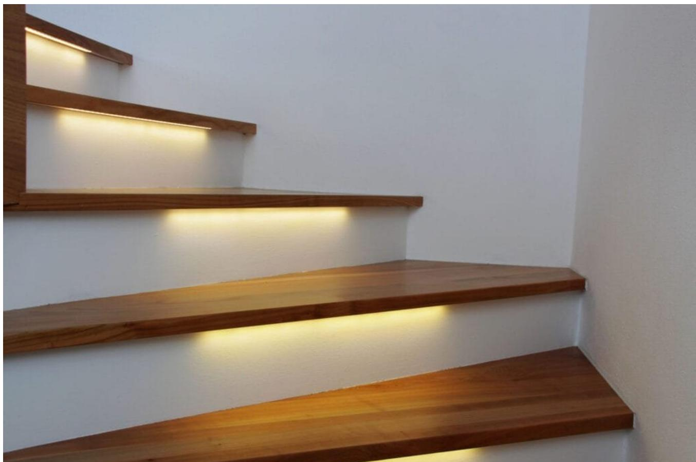
LED-Stripes lassen heute völlig neue Beleuchtungsvarianten zu. So lassen sie sich unter Treppenstufen kleben und erhöhen so die Sicherheit. Auch LED im Handlauf, die nach unten auf die Treppenstufen leuchten, sind gleichermaßen schön und sicher. Foto: WoGi/www.stock.adobe.com
