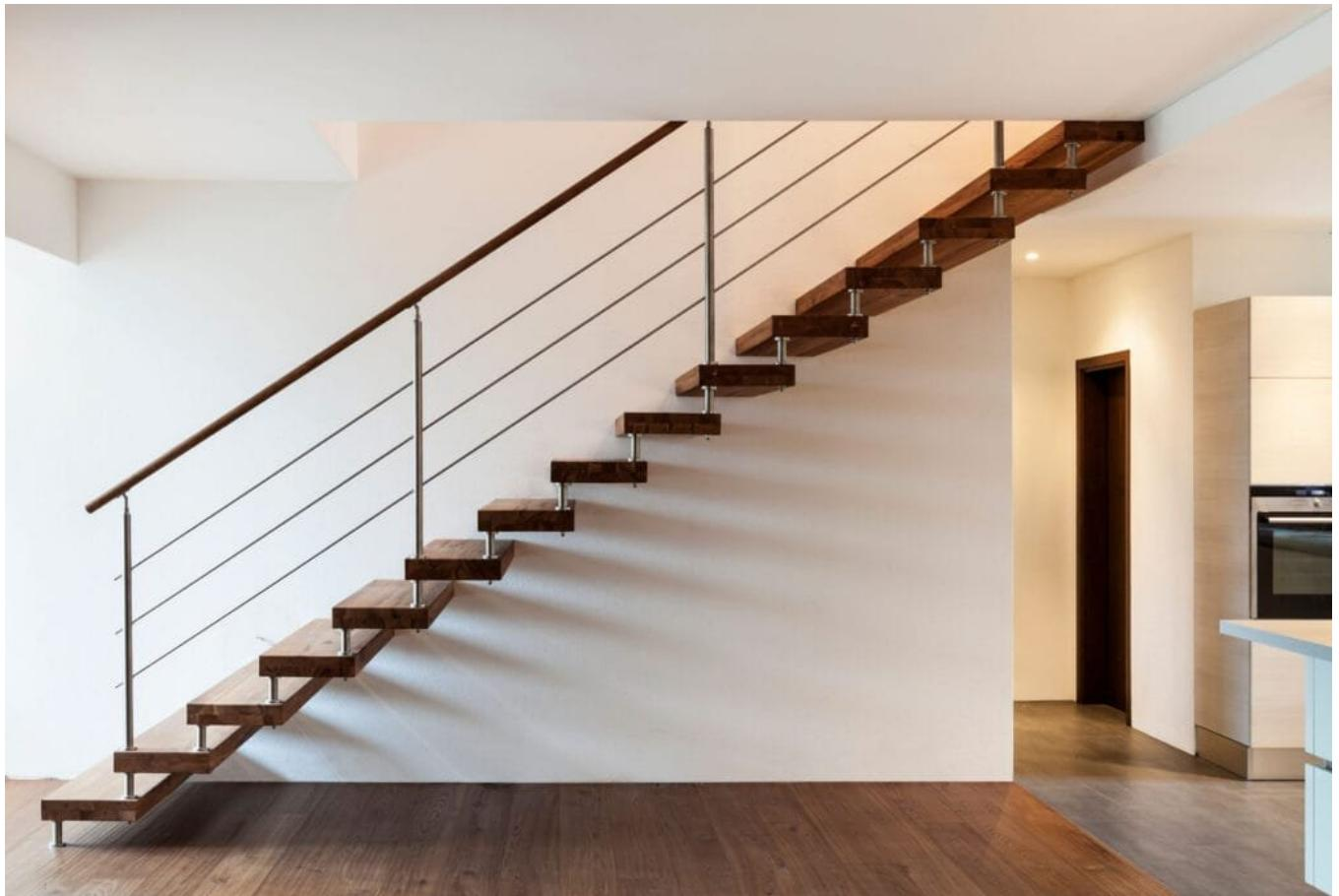
Handlaufgetragene Treppen wirken besonders leicht und filigran: Sie benötigen aber eine stabile, begleitende Wand, an der die Stufen wandseitig befestigt werden können. An der freien Seite sorgen die Geländerstäbe mit einem statisch tragenden Handlauf für Stabilität. Foto: alexandre zveiger/www.stock.adobe.com
