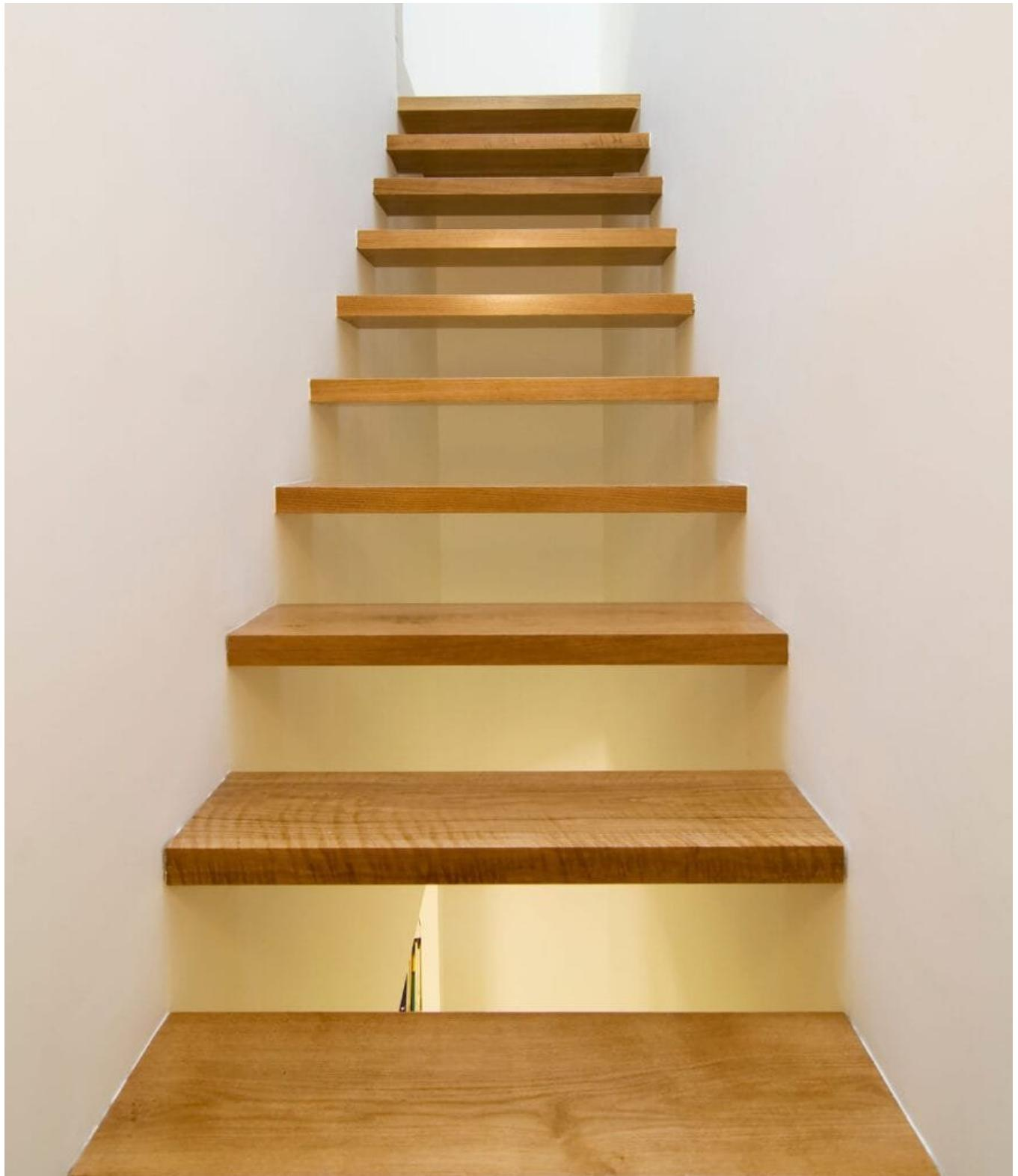
Treppentyp: Sind die Trittstufen durch vertikale Setzstufen miteinander verbunden, ist die Treppe geschlossen, im Gegensatz zur offenen Treppe, bei der man durch die Stufen hindurchsehen kann. Die Begriffe verraten bereits, wie die jeweiligen Treppen im Raum wirken: eher leicht und luftig bzw. solide und stabil. Fotos: Studio D; nosha/www.stock.adobe.com
