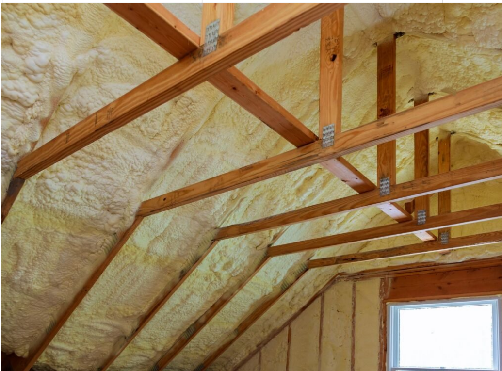
Nichts geht ohne Wärmedämmung von innen.
