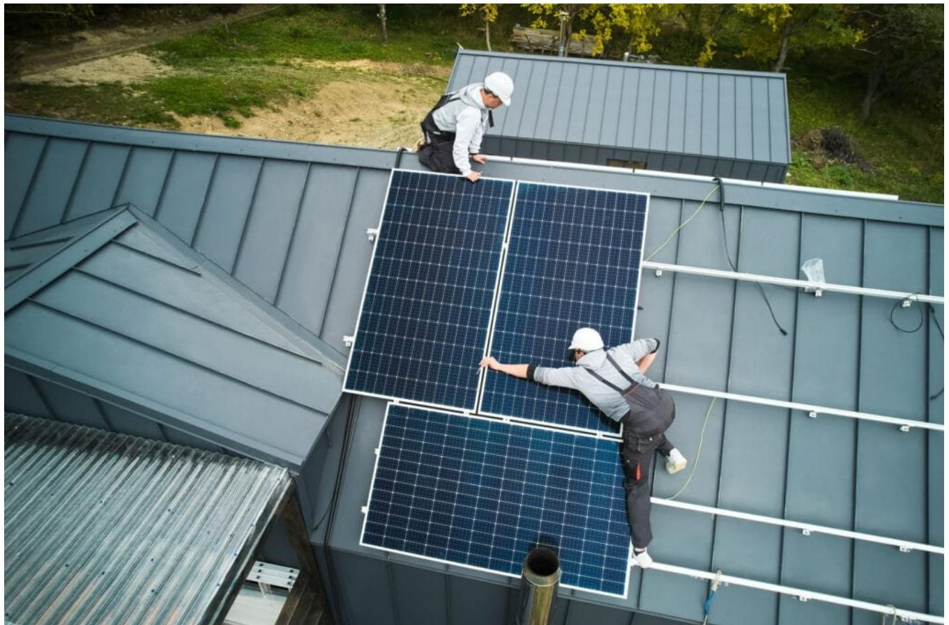
Mithilfe von Photovoltaikmodulen lässt sich einfach und günstig Strom für die Verwendung im eigenen Haushalt generieren. Für optimale Ergebnisse sollten Dachflächen zur Sonne orientiert und nicht verschattet sein.
