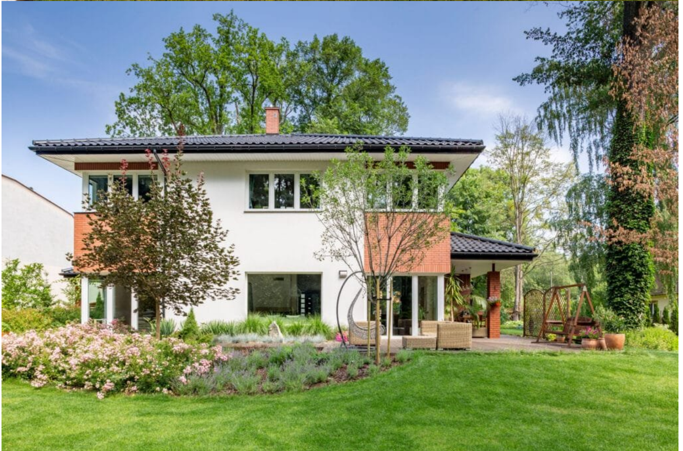
Die Wahl der Dachform beeinflusst die architektonische Wirkung des Hauses. Fotos: links luisviegas, rechts bialasiewicz/www.elements.envato.com
