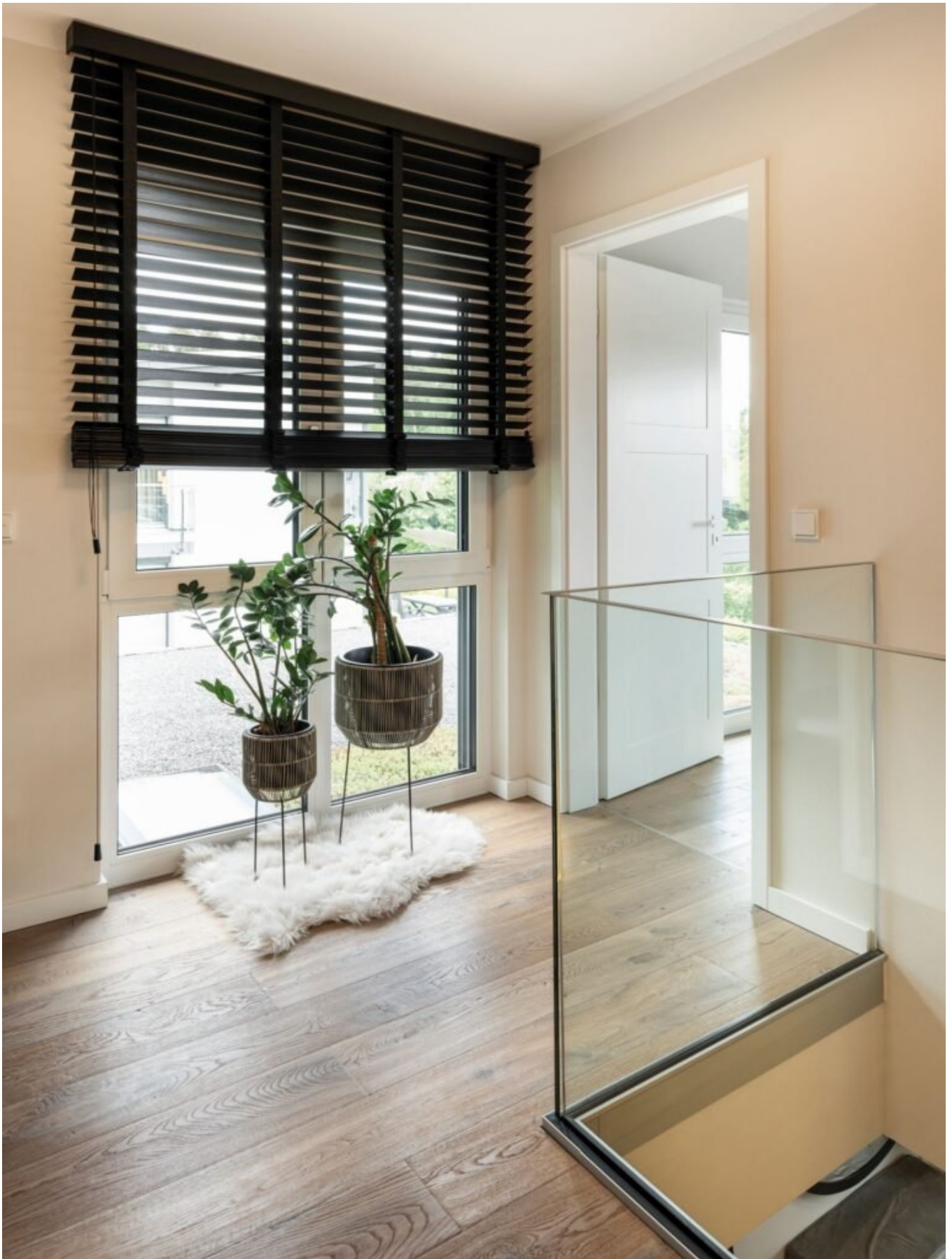
Als Absturzsicherung im Obergeschoss wählte die Baufamilie um die Treppenöffnung herum eine Brüstung aus Sicherheitsglas. So wirkt der, dank bodentiefer Fenster sehr helle Flur, von dem die Privaträume der Familie erschlossen werden, großzügiger. Fotos: FingerHaus GmbH / Katharina Jaeger, fotografische Werkstatt
