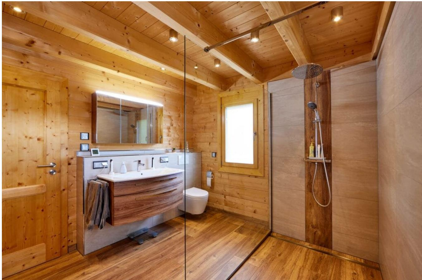
Die gefliesten Oberflächen in Dusche und am Waschtisch bestehen aus von der Blockbohlen-wand entkoppelten Vorwände. Der „Holzboden“ in diesem Raum besteht aus pflegeleichten Fliesen in Holzoptik.
