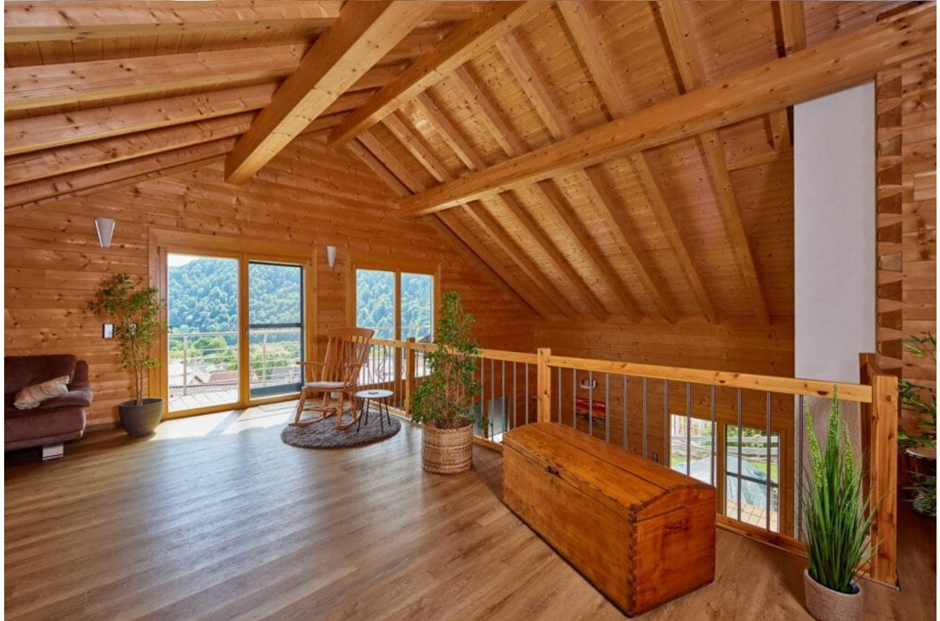
Auch das Hausinnere ist vom Baustoff Holz geprägt. Die glatt gehobelten Blockwände bilden hier die sichtbare Oberfläche - das hat den Arbeitsaufwand beim Innenausbau deutlich reduziert: es war kein verputzen und kein streichen notwendig.
