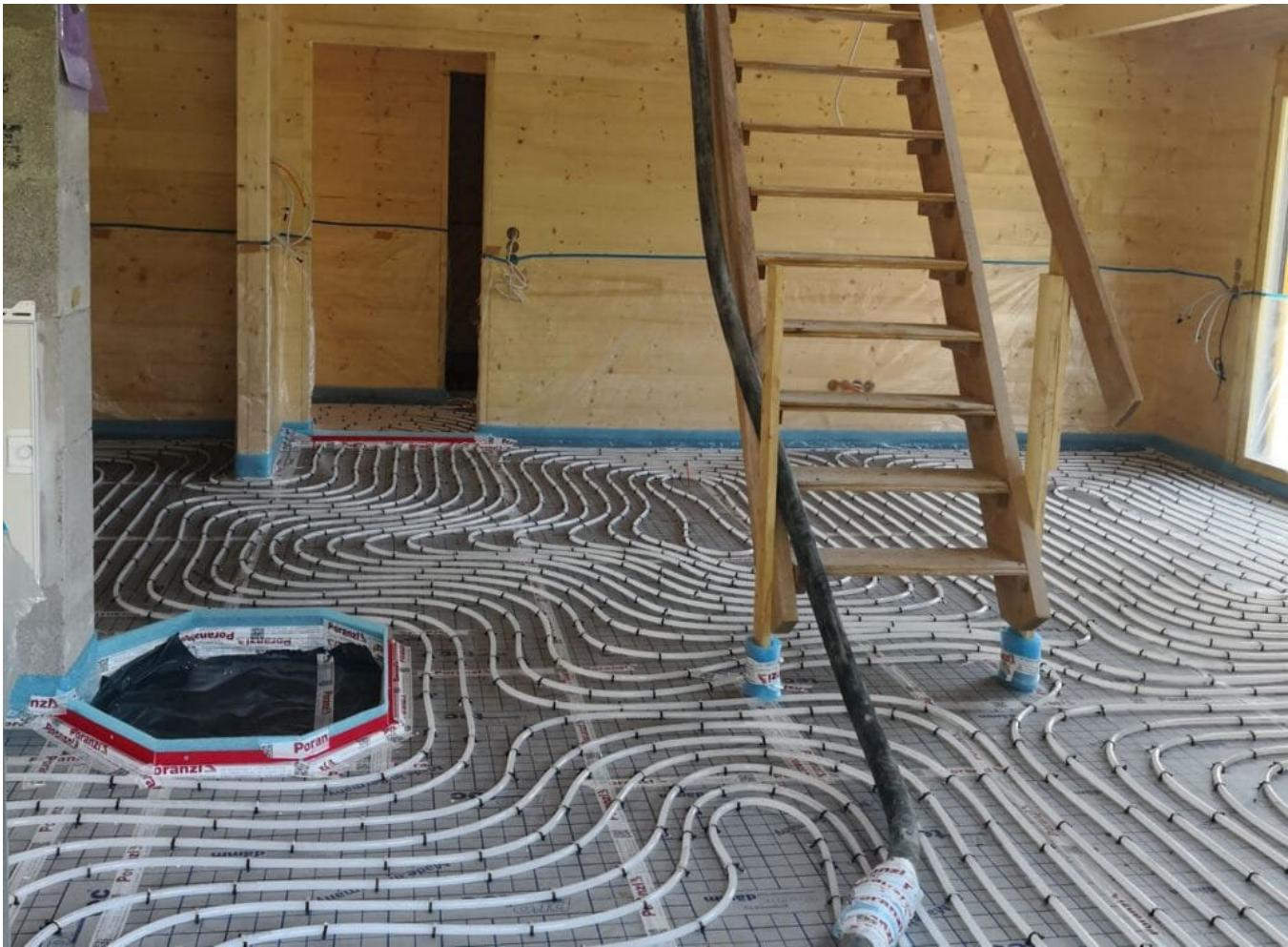
Das Außengerät der Luft-Wasser-Wärmepumpe steht auf der Nord-Ost-Seite des Hauses, sodass die Terrasse und die Freisitzplätze der Köblers weder optisch noch akustisch gestört werden. Der selbst auf dem Dach erzeugte Sonnenstrom deckt einen Großteil der Heizkosten. Verteilt wir die regenerative Wärme im Haus über eine Fußbodenheizung.
