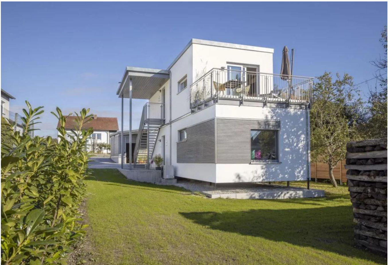
Flying Space-Module lassen sich auch zumehrgeschossigen Gebäuden stapeln. Fotos und Grafiken: Schwörer Haus
