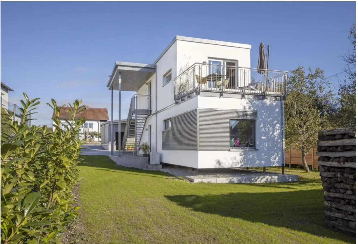
Flying Space-Module lassen sich auch zu mehrgeschossigen Gebäuden stapeln.
